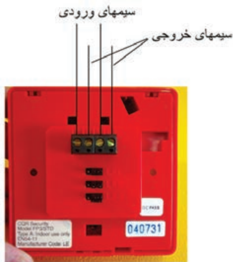
شکل ۳۹-۱ سیمهای اتصال شستی
