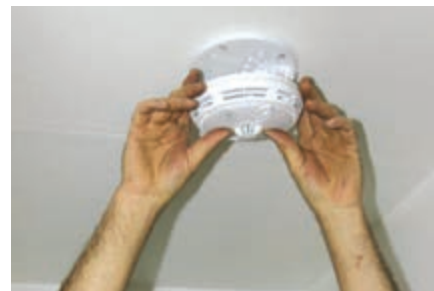
شکل ۱-۱۵ قرار دادن یک نوع آشکارساز روی پایه
