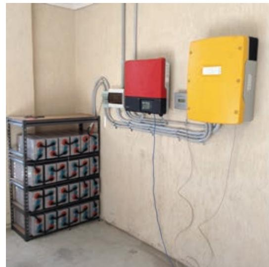
شکل ۶۱- اتصالات سیستم فتوولتاییک
