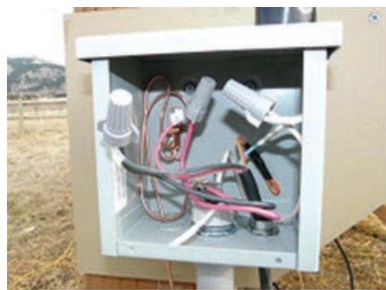
شکل ۳۵- اتصال میله مسی به بدنه تابلو اتصالات
