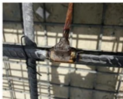
شکل ۱۱- اتصال‌هادی همبندی مسی به میلگردهای موجود در سازه با استفاده از جوش احترaci
