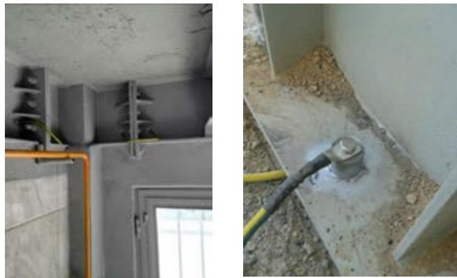
شکل ۲۴-اتصال اسکلت فلزی پیچی
