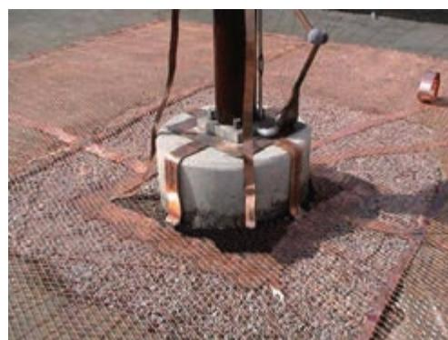
شکل ۴ – حلقه کلاف مسی به دور سازه فلزی برای همبندی
